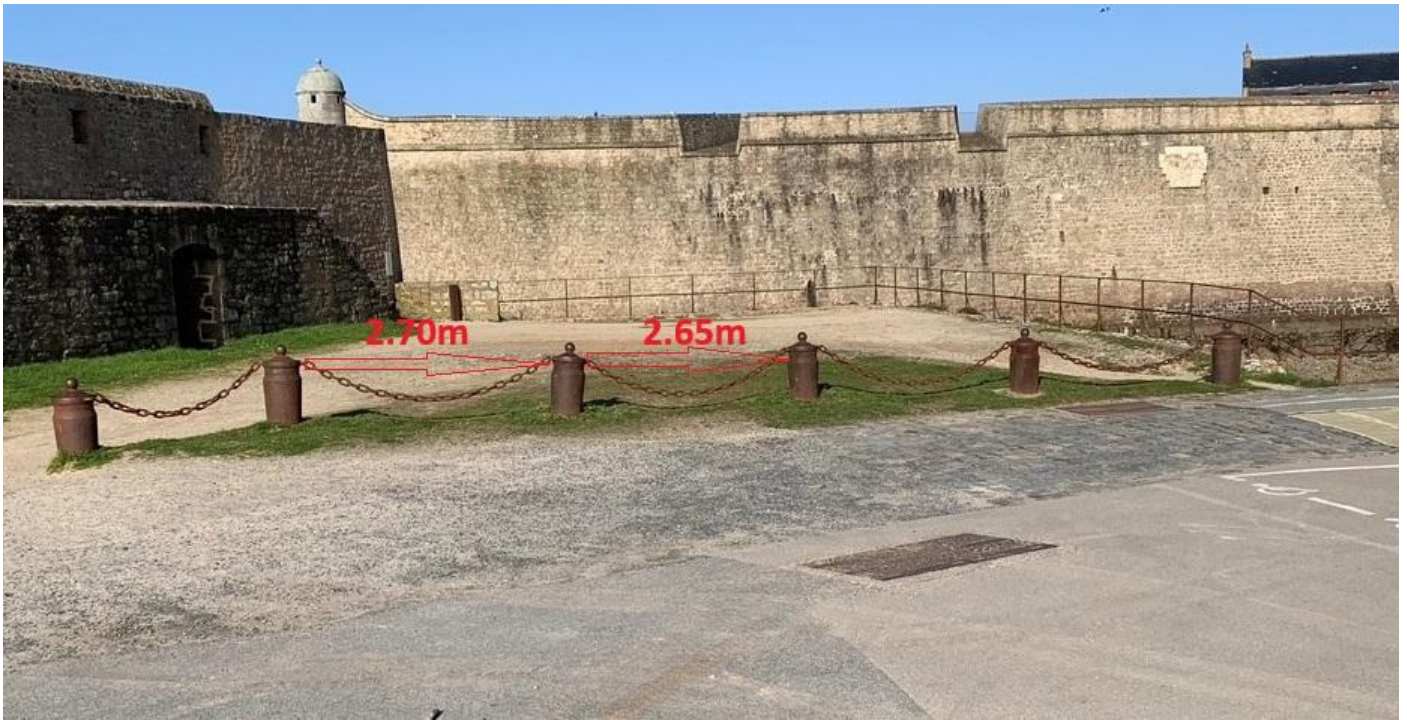
Vues du terre-plein devant le Bastion Saint-Nicolas :
